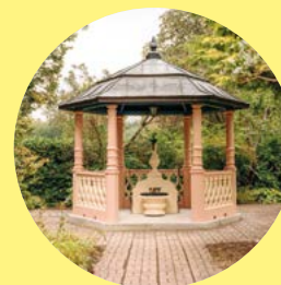
Brunnen i Brunnsparken är åter i fint skick efter renovering. Foto: Sofia Wigén
